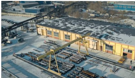
Новая производственная площадка по адресу: Кольевское шоссе, 40, 2017-2018 г.
